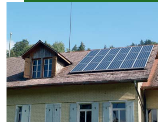
Photovoltaikanlage: Jugendliche haben bei der Installation kräftig angepackt.
