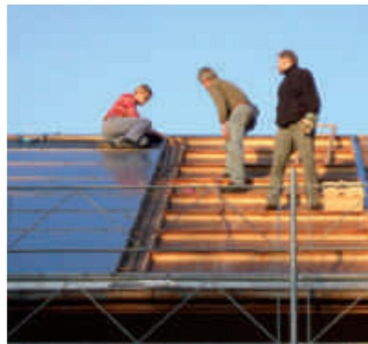
Die bestehenden Solaranlagen wurden demon- tiert und wieder aufs neue Dach montiert.
