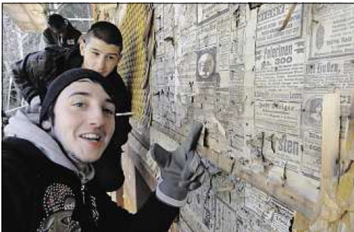
Stellenlose Jugendliche beim Abbruch der alten Fassade des Hauses Jugendalp Eigenthal: Unter den alten Holzschindeln ist das Haus mit Zeitungen von anno 1899 tapeziert.
