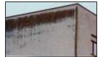
Konstruktiver Holzschutz fehlt
