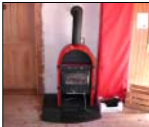
Die bestehende Holzheizung im Esssaal.
