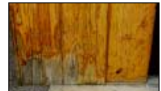
Konstruktiver Holzschutz fehlt
