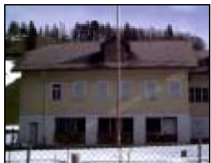
Der ungeheizte Gebäudeteil
