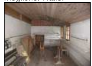
Möglicher Materialraum im Anbau.
